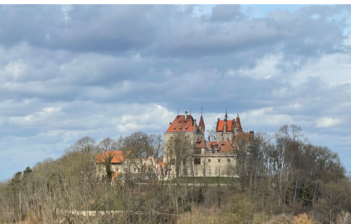
Die Burg Calenberg bei Warburg in ihrem heutigen Zustand. Foto: LWL/Michael Lagers.
